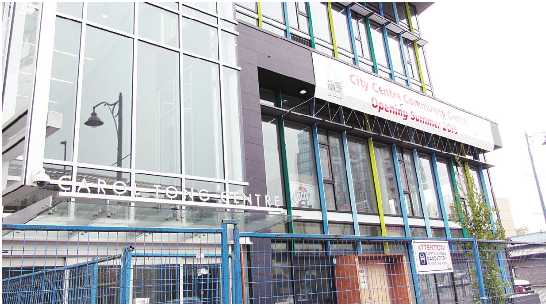
▲ Carol Tong Centre 的建造工程仍在進行中，設於大樓一樓及二樓的市中心社區中心，預期將於夏季正式啟用。(鄭綺儀攝)
