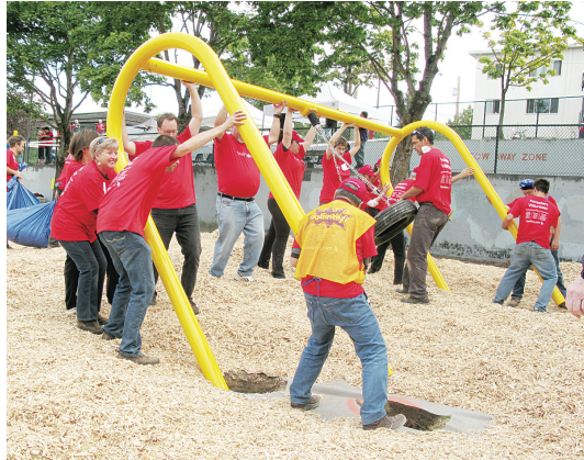
義工正將鞦韆的結構扶直。(張伶銖攝)
