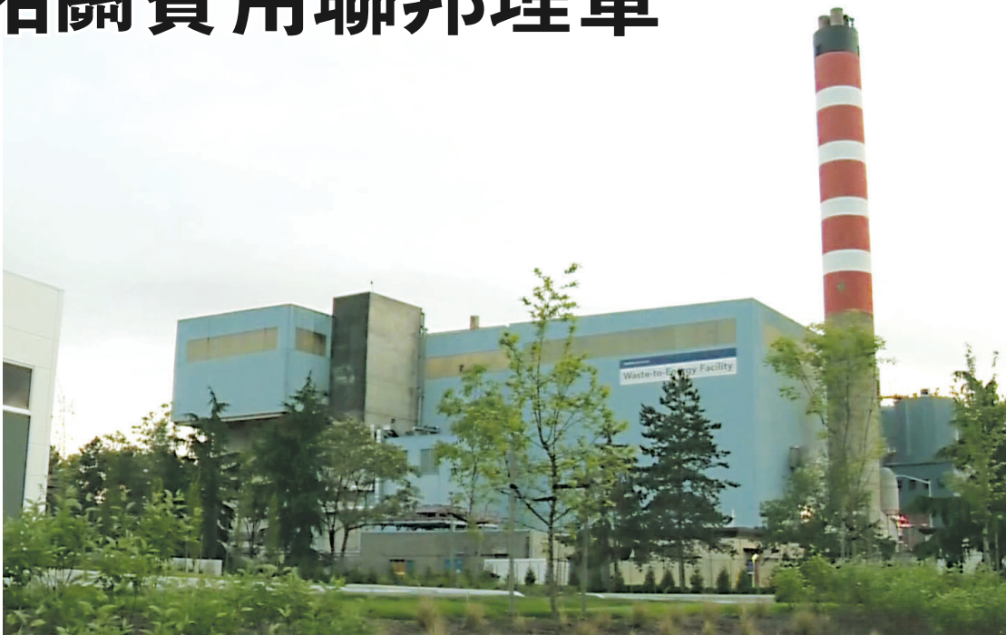
本那比垃圾焚化發電廠。
