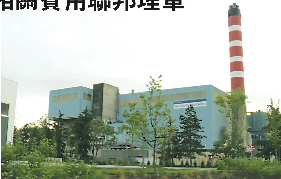
本那比垃圾焚化發電廠。
