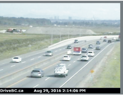
通過公路攝錄機可即時了解路面交通狀況。
