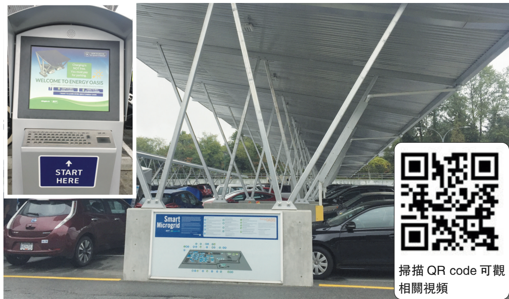
停車場屋頂即是太陽能板。小圖為BCIT太陽能充電站。
