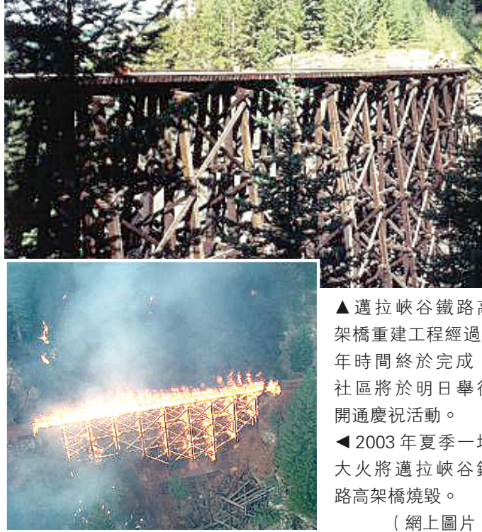
▲邁拉峽谷鐵路高架橋重建工程經過3年時間終於完成，社區將於明日舉行開通慶祝活動。
