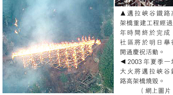
▲邁拉峽谷鐵路高架橋重建工程經過3年時間終於完成，社區將於明日舉行開通慶祝活動。 ◀2003年夏季一場大火將邁拉峽谷鐵路高架橋燒毀。（網上圖片）
