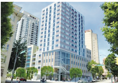
位於西摩街的新社區房屋竣工。(市府提供)
