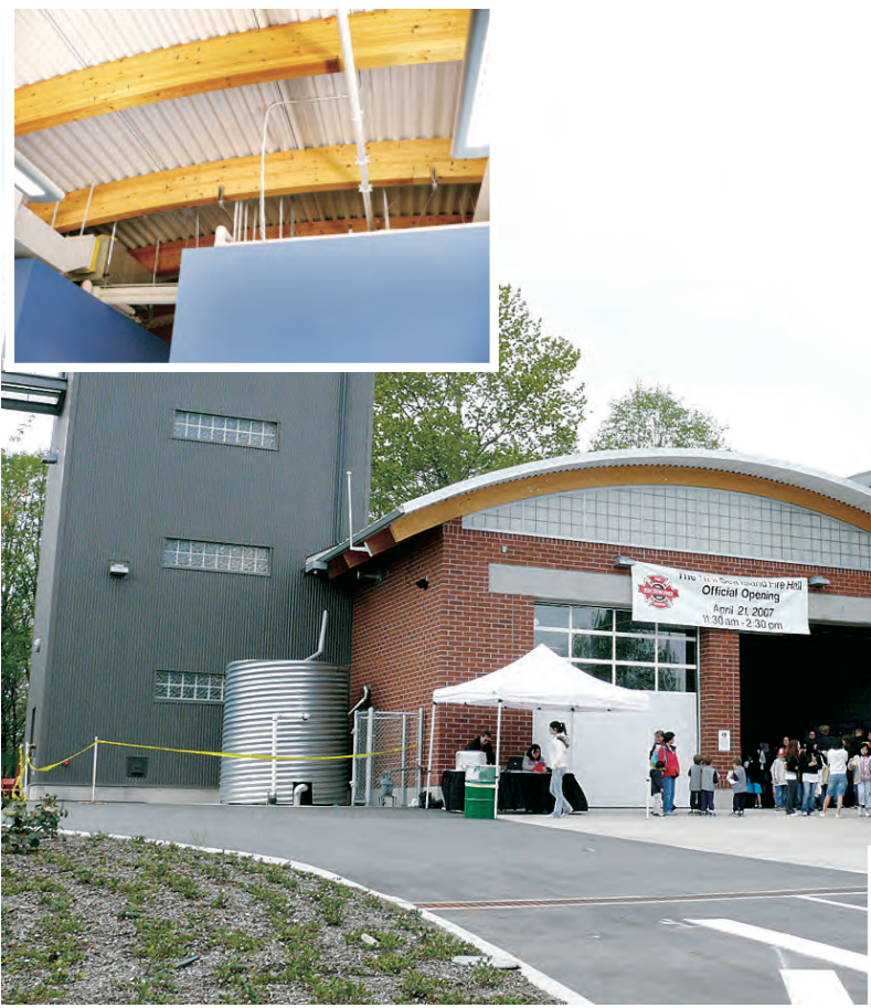
左上：建築間隔上部留空，沒有完全封閉到天花板上，以保持室內各房間空氣流動。 中：列治文首個融入環保概念的綠色消防局建築。 右下：綠色的屋頂花園設計，不僅可以降低建築溫度，也可以在都市中營造小型天然生態。(蘇立立攝)
