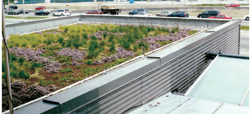
左上：建築間隔上部留空，沒有完全封閉到天花板上，以保持室內各房間空氣流動。 中：列治文首個融入環保概念的綠色消防局建築。 右下：綠色的屋頂花園設計，不僅可以降低建築溫度，也可以在都市中營造小型天然生態。(蘇立立攝)
