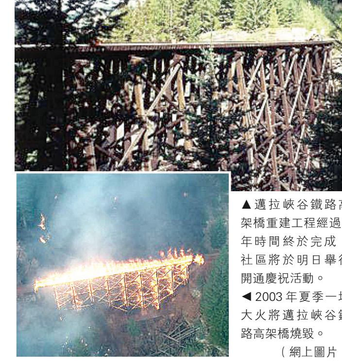
▲邁拉峽谷鐵路高架橋重建工程經過3年時間終於完成，社區將於明日舉行開通慶祝活動。▲2003年夏季一場大火將邁拉峽谷鐵路高架橋燒毀。（網上圖片）
