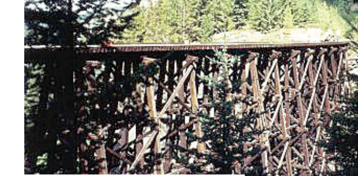
▲邁拉峽谷鐵路高架橋重建工程經過3年時間終於完成，社區將於明日舉行開通慶祝活動。 ▲2003年夏季一場大火將邁拉峽谷鐵路高架橋燒毀。（網上圖片）
