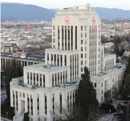
溫哥華擬拆市政大樓東翼危樓。（資料圖片）
