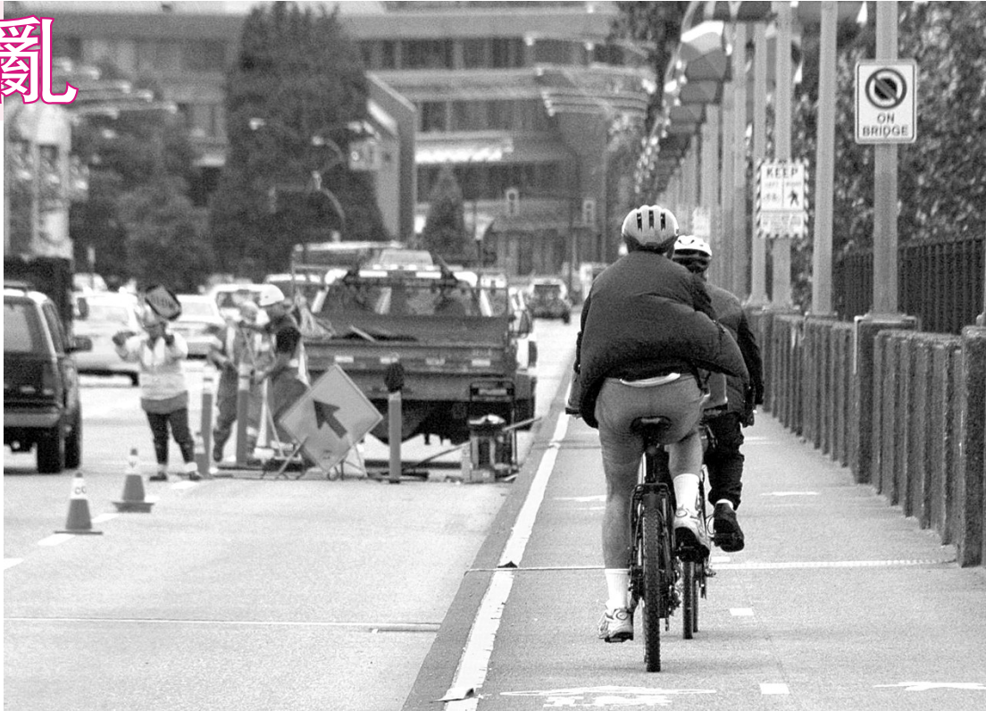
溫市政府人員昨天在布勒橋上進行單車專用線的預備工程。（蕭良文攝）
