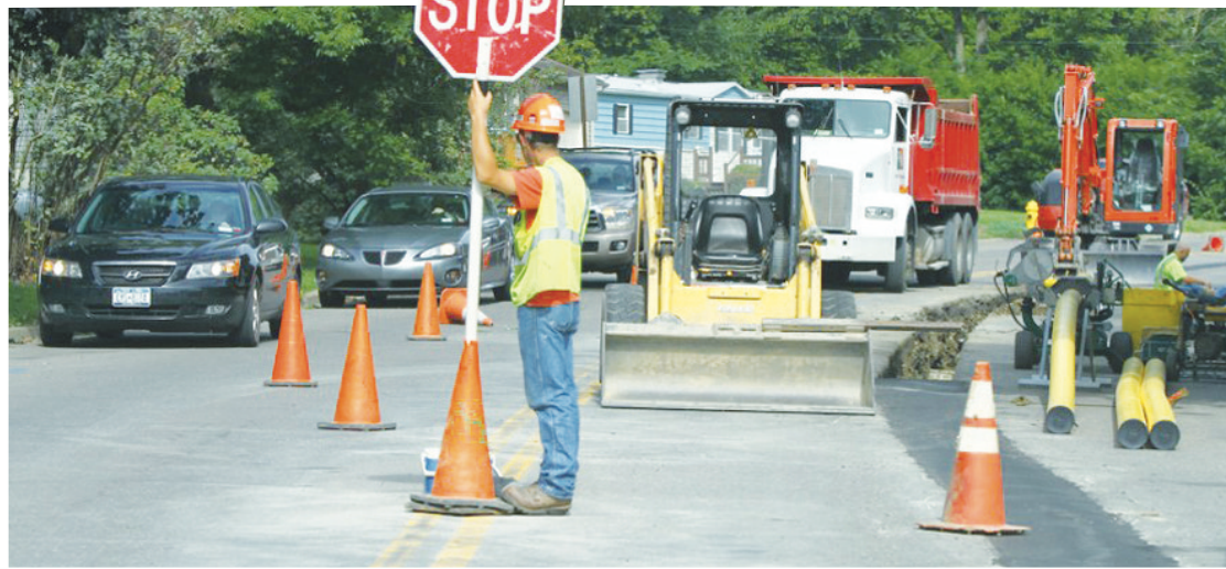
指揮交通的道路工人最易被汽車撞倒。
