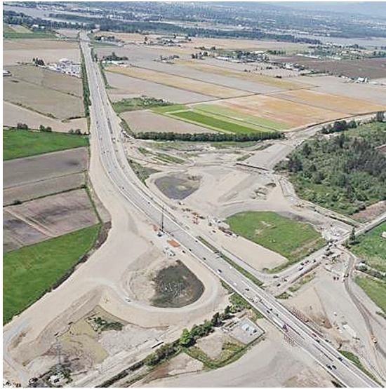
南菲沙繞道部分路段已竣工。（省府圖片）
