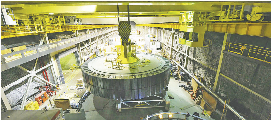
兩個新增發電機組可增加容量約1000百萬瓦特。（卑詩水電公司網站視頻截圖）
