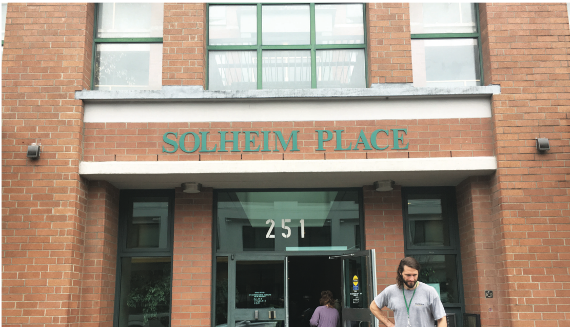
高層升降機恢復運作，華埠順利樓租戶舒一口氣。
