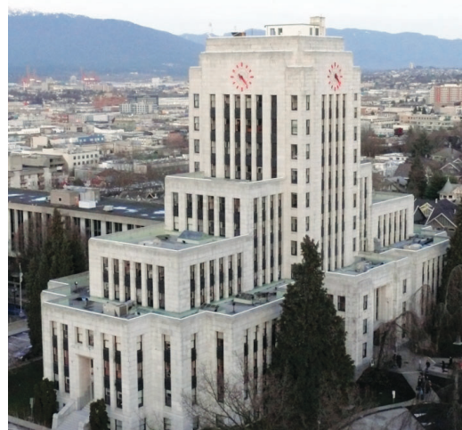
溫哥華擬拆拆市政大樓東翼危樓。（資料圖片）
