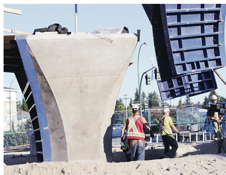
長青線首個高架路軌橋墩完成，圖為工人正在施工。
