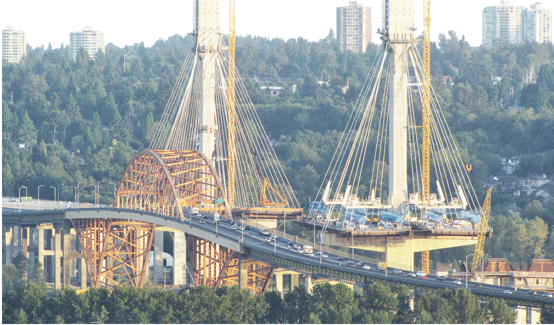
新曼港橋工程已完成一半。(省政府提供)
