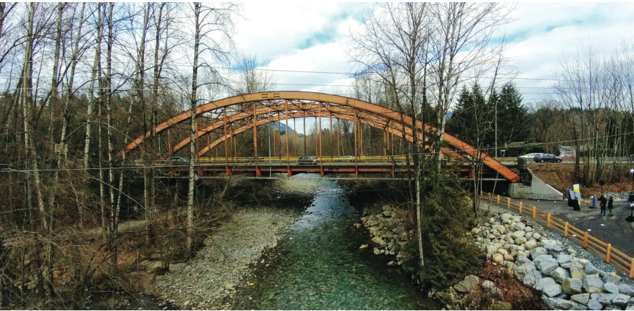
1號公路下林谷走廊工程的第四期會包括在林溪橋兩旁建有新橋。（卑詩政府提供）
