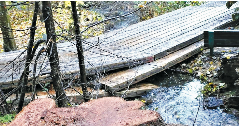
▲施工隊興建臨時木橋，供推土機過溪。（普賴斯爾提供） ▶推土機壓塌臨時木橋。（普賴斯爾提供）
