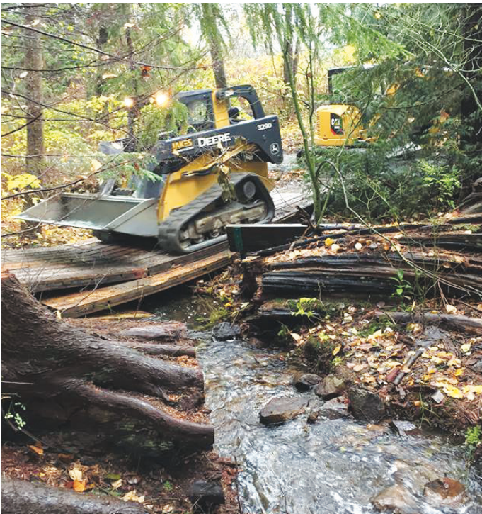
▲施工隊興建臨時木橋，供推土機過溪。（普賴斯爾提供） ▶推土機壓塌臨時木橋。（普賴斯爾提供）
