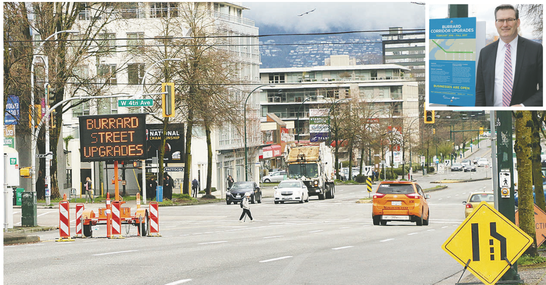
施工路段旁已有指示牌及電子屏幕提醒市民注意。小圖為多布羅沃爾尼建議市民改用甘比橋或格蘭護橋來往市中心。（王學文攝）
