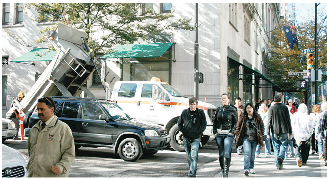
漢比街單車道開始施工，對附近交通造成影響。（馮亮攝）
