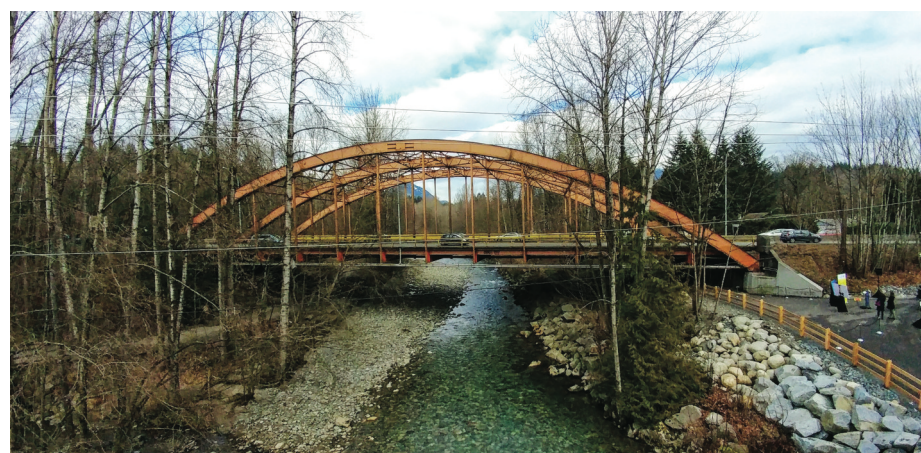
1號公路下林谷走廊工程的第四期會包括在林溪橋兩旁建有新橋。
