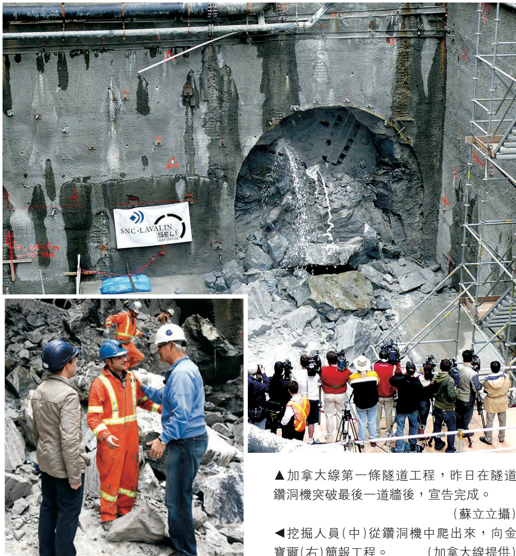
▲加拿大線第一條隧道工程，昨日在隧道鑽洞機突破最後一道牆後，宣告完成。(蘇立立攝)
