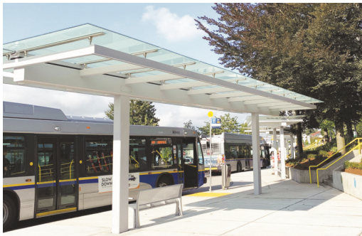
22街巴士轉車站翻新工程完成。（運聯提供）
