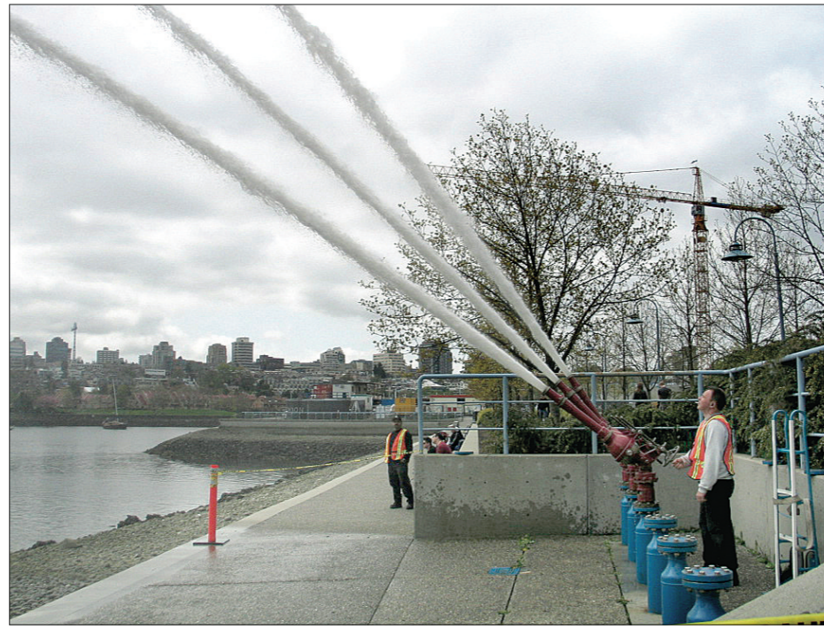
▲高壓水柱噴上空中，使用的是海水。 ▶溫市中心林思齊公園旁的水壓站，可以抽取海水救火。(王介中攝)
