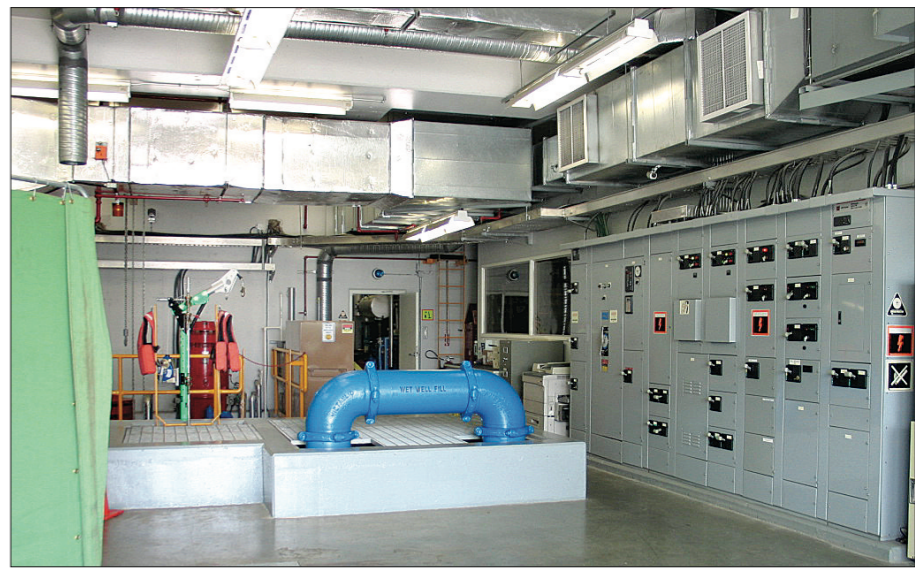
▲高壓水柱噴上空中，使用的是海水。 ▶溫市中心林思齊公園旁的水壓站，可以抽取海水救火。(王介中攝)
