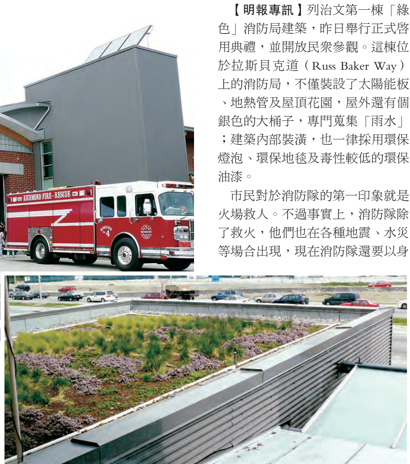
左上：建築間隔上部留空，沒有完全封閉到天花板上，以保持室內各房間空氣流動。 中：列治文首個融入環保概念的綠色消防局建築。 右下：綠色的屋頂花園設計，不僅可以降低建築溫度，也可以在都市中營造小型天然生態。(蘇立立攝)
