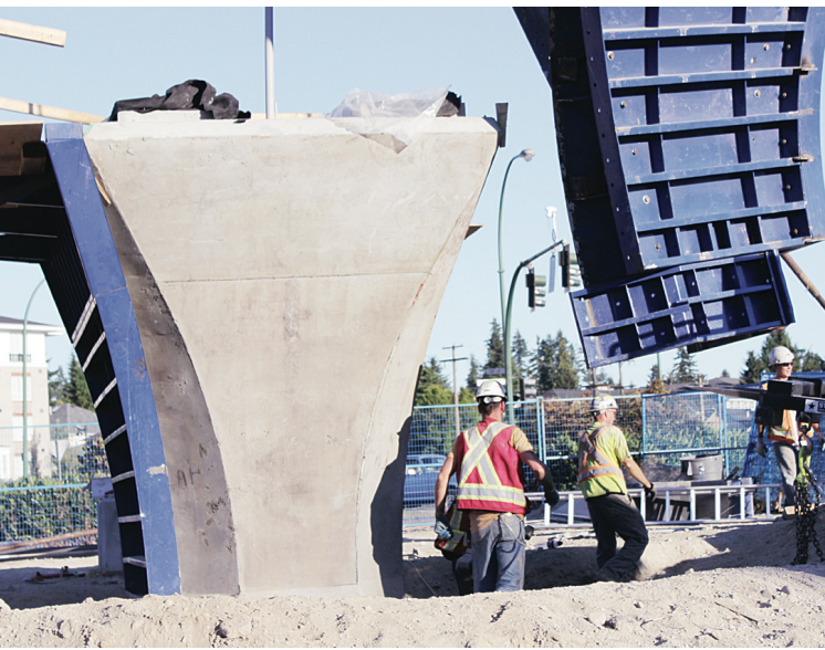
長青線首個高架路軌橋墩完成，圖為工人正在施工。(卑詩政府提供)
