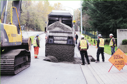
工人加緊施工，填補地洞。(呂寒攝)
