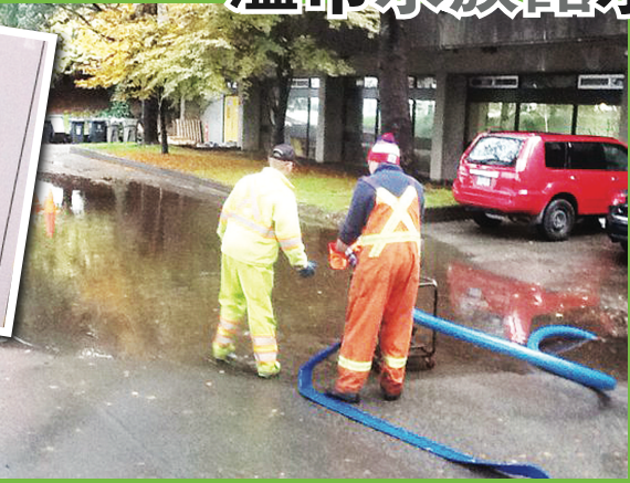
水上活動中心進水，工人抽水。(Twitter相片@GS_Harper)
