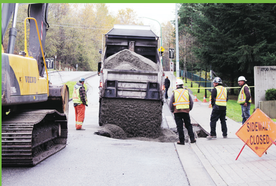
工人加緊施工，填補地洞。(呂寒攝)
