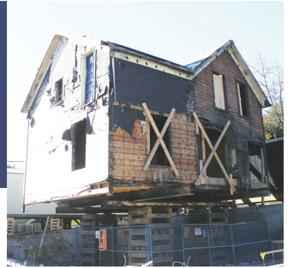
▲由康拉德家族擁有的 1911 年古屋被改建成四個住宅單位，需要重建地基。(司徒永業攝)
