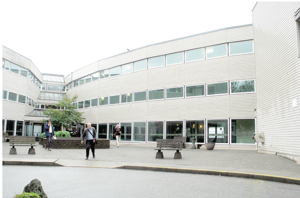
許多可負擔房屋，均由一些舊建築翻新而成。
