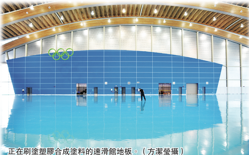
正在刷塗塑膠合成塗料的速滑館地板。（方潔瑩攝）
