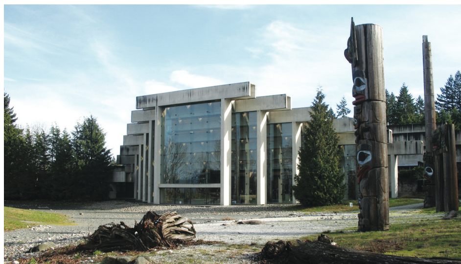
卑大的人類學博物館部分建築被指在地震中有非常高風險會倒塌。（資料圖片）
