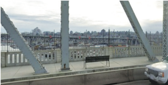
▲布勒橋設有防自殺的安全柵欄。（谷歌地圖）
