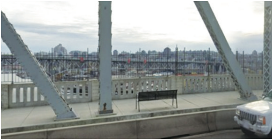
▲布勒橋設有防自殺的安全柵欄。（谷歌地圖）
