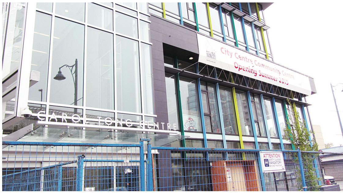
▲ Carol Tong Centre 的建造工程仍在進行中，設於大樓一樓及二樓的市中心社區中心，預期將於夏季正式啟用。(鄭綺儀攝)
