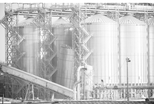
北溫貨運設施其中一個筒倉塌下。（加新社）
