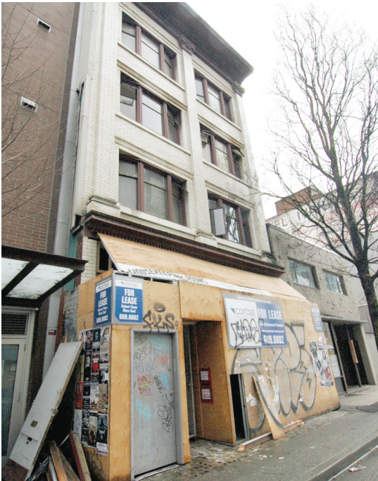
緬街 900 號路段正在進行改建的可負擔房屋。 (呂寒攝)
