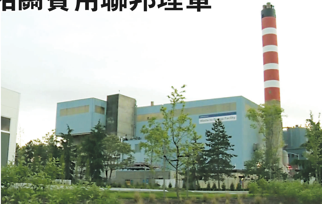
本那比垃圾焚化發電廠。
