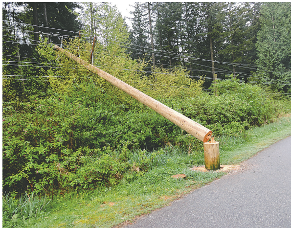
架有高壓電線的木柱被電鋸鋸斷倒下。（卑詩水電局相片）
