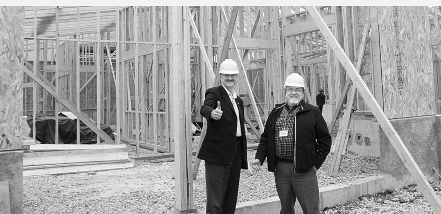
畢貝爾 (左) 和 Frank Everitt 在四川省北川縣一間正在施工的老人院前合照。(卑詩省政府提供)
