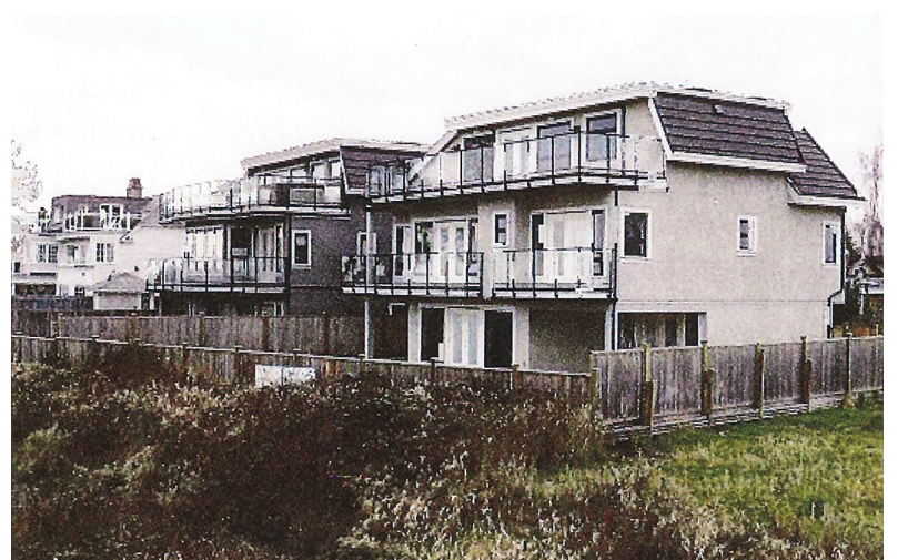
列治文市政府，對三層高平頂住宅房屋的結構，進行檢討研究。(市府圖片)
