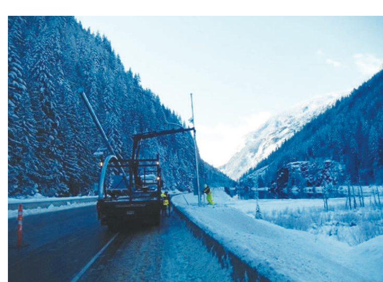
省府開始在3條高速公路上，安裝可以根據天氣變化設置不同的速度限制的電子顯示牌。（省府圖片）
