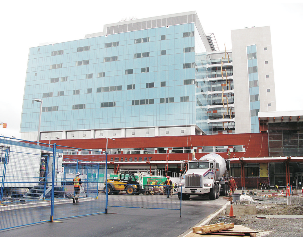
素里紀念醫院擴建工程正在趕工當中。（張伶銖攝）
