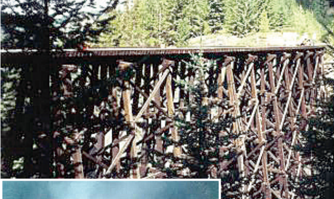
▲邁拉峽谷鐵路高架橋重建工程經過3年時間終於完成，社區將於明日舉行開通慶祝活動。 ◀2003年夏季一場大火將邁拉峽谷鐵路高架橋燒毀。（網上圖片）
